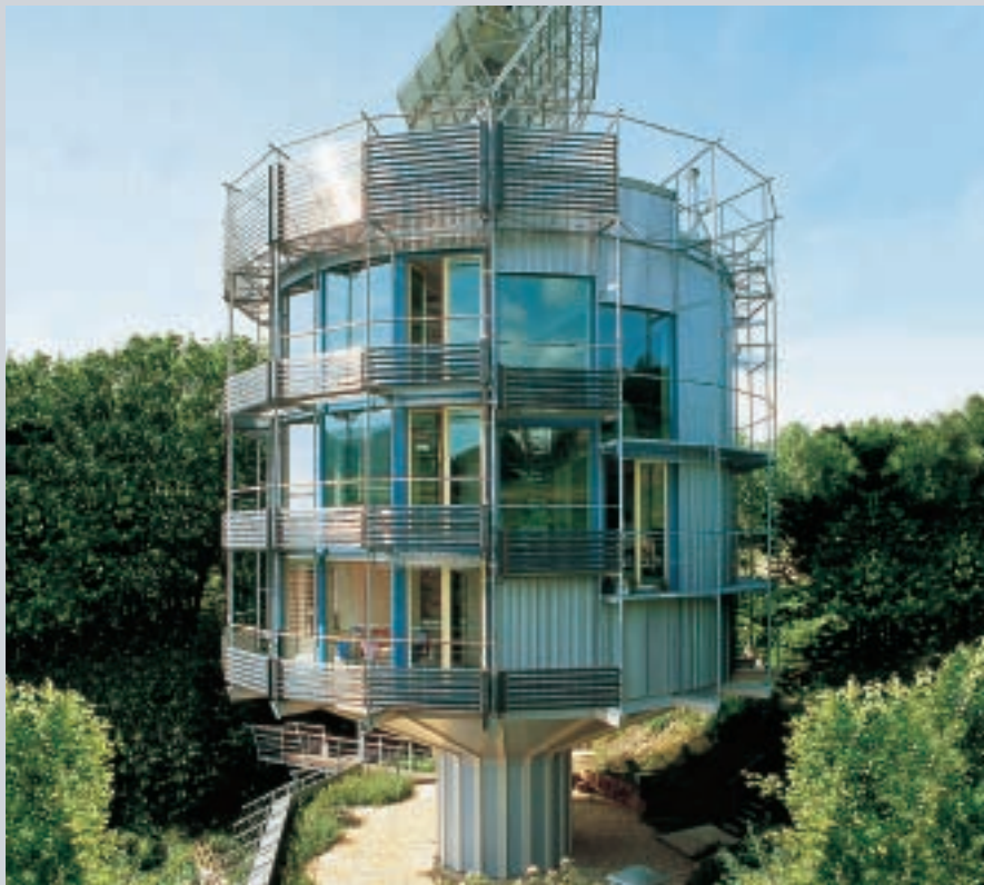
Fig. 47 : Heliotrope, Fribourg avec capteurs à tubes sous vide
