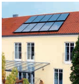
Vitosol 200-FM en place sur un bâtiment collectif
