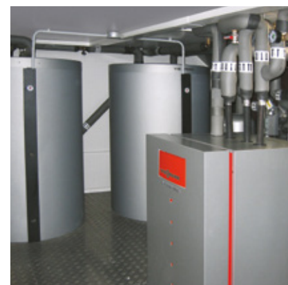
Pompe à chaleur Vitocal 300 avec ballon tampon Vitocell 100-E et ballon d'eau chaude sanitaire Vitocell 100-L
