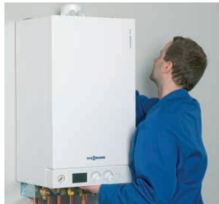
2. Montage de la chaudière
