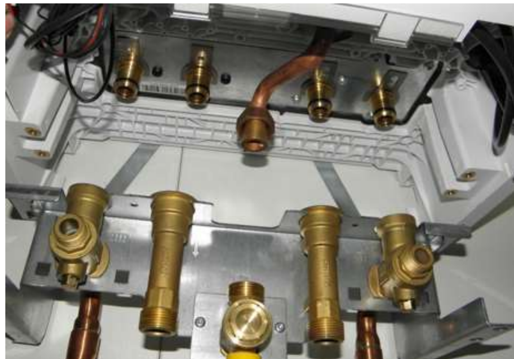
Console de raccordement chauffage et eau chaude sanitaire avec connecteurs. Le raccordement gaz uniquement doit encore être vissé.
