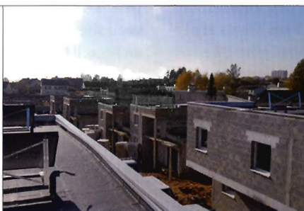
▲ Le pack solaire Viessmann de chaque logement comprend 4 m 2 de capteurs, une chaudière gaz à condensation et un ballon solaire intégré. © DR
