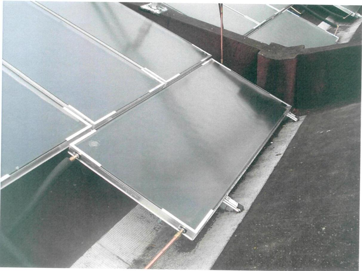
Les modules sont de marque viessmann. La partie absorption est composée en partie de cuivre. La couverture est constituée d'un verre solaire de 3,2mm.
