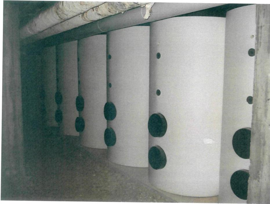
Les 10 ballons tampons sont de marque viessmann ils contiennent chacun 1500L d'eau, chauffée via les panneaux solaires thermiques. Ils sont équipés de jaquettes en mousse souple, d'épaisseur 100mm.
