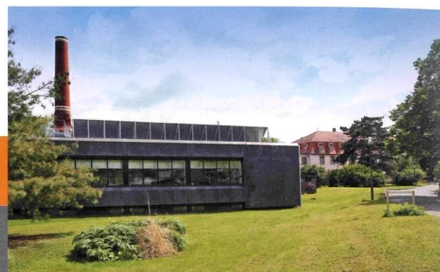
▲ Le bâtiment de la cuisine centrale.
