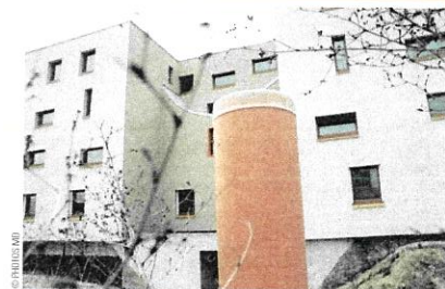
Le puits canadien dispose d'une prise d'air implantée en périphérie de l'accès au parking. Il est constitué de cinq tubes enterrés de 30 m de longueur en polyéthylène alimentaire pour un débit de 1 500 m 3 /h.
