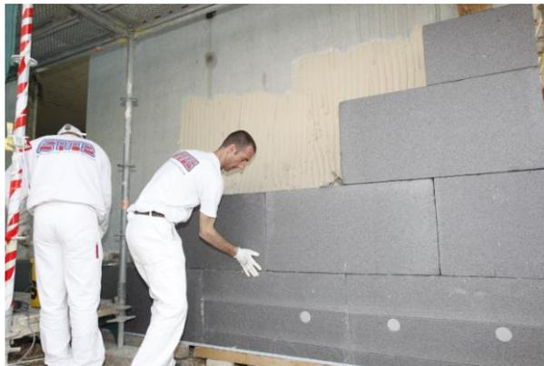
Pose de l'isolation thermique par l'extérieur sur «la Clairière» au printemps 2009 par l'entreprise SAPE
