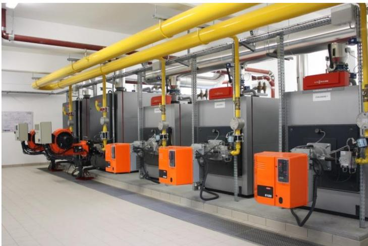
Pilotées par une GTC, les chaudières VIESSMANN équipées de brûleurs modulants CUENOD, peuvent totalement exprimer leurs spécificités en matière de simplification hydraulique. En effet, exempte d'auxiliaires primaires, l'installation a la capacité de ne
