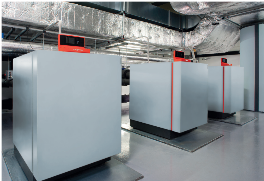
Pompe à chaleur Vitocal 300-G Puissance de chauffage en version pompe à chaleur seule : de 21,2 à 42,8 kW, et en version maître/esclave : de 42,4 à 85,6 kW, 428 kW maximum (en cascade)
